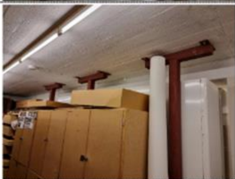
B-086 Stållforsterking i magasinrom av dekke under utstilling.
