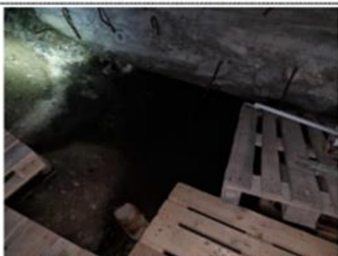
B-051 Stående vann i krypkjeller under Rotunden
