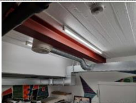
B-090 Stålförsterking i magasinrom av dekke under utstilling.
